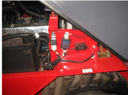
Relais und Hauptsicherung über dem rechten Hinterrad
