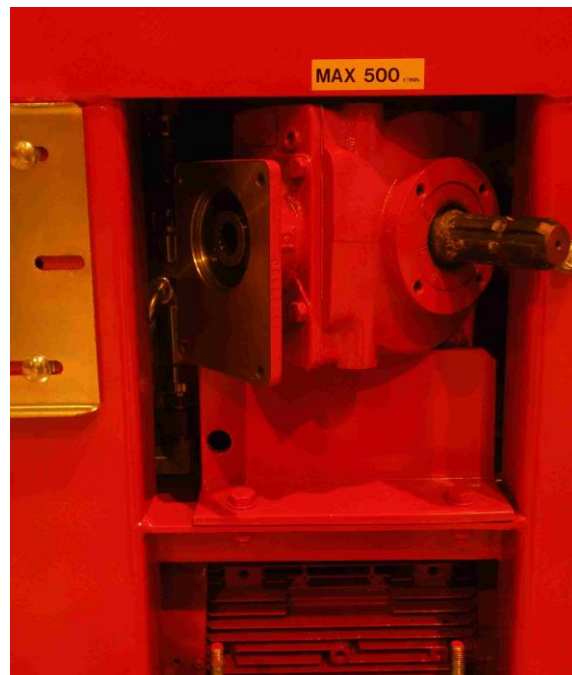
Bild 23. Byte av vinkelväxel.
