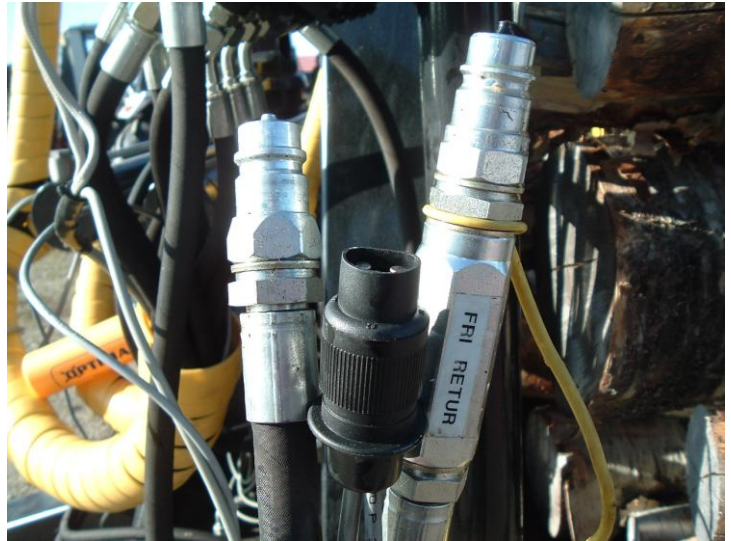
Raccordements hydrauliques et électriques de la grue et des béquilles (sur une remorque avec distributeur léger).
