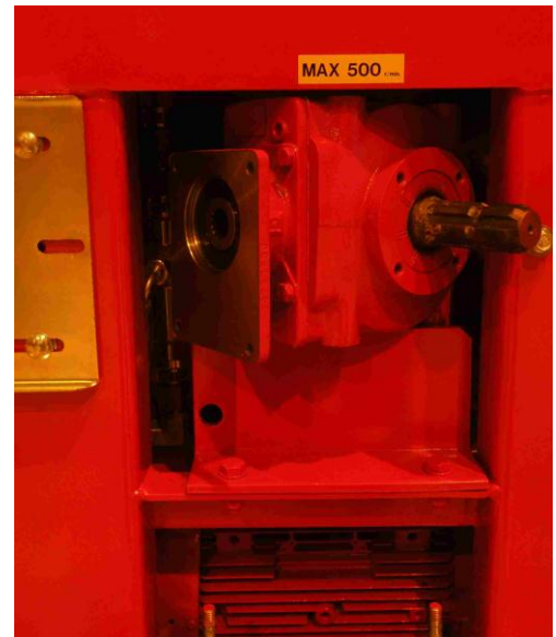
Bild 23. Byte av vinkelväxel.
